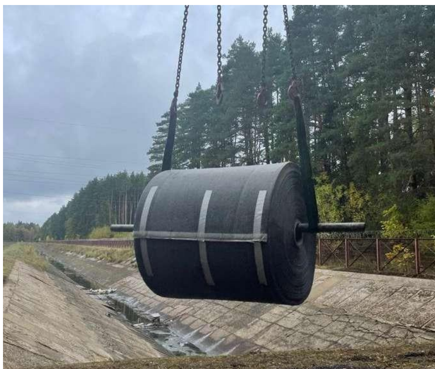
Рисунок 1. Общий вид рулона и структура бетонного полотна
